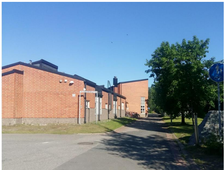
Kuva 8 Päiväkoti kuvattuna idän suunnasta. Kuvassa näkyy rakennuksen keskivaiheilla oleva ns. uloke, joka työntyy rakennuksesta kevyen liikenteen väylälle.
