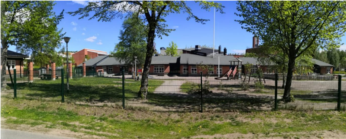
Kuva 7 Päiväkoti pihan puolelta kuvattuna.
